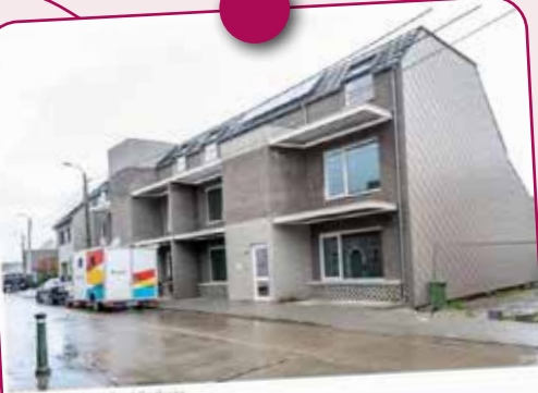
Bouwwerkzaamheden in Dendermonde. © Dendermonde
