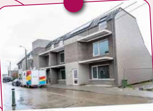
Bouwwerkzaamheden in Dendermonde. © Dendermonde
